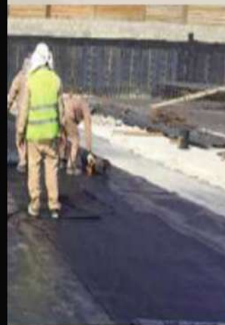
عزل لفائف البيتومين Bitumen membrane insulation
