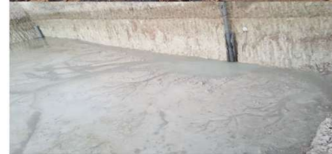
أعمال نزح المياه Dewatering
