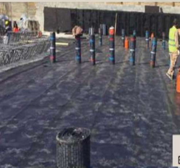
عزل لفائف البيتومين Bitumen membrane insulation
