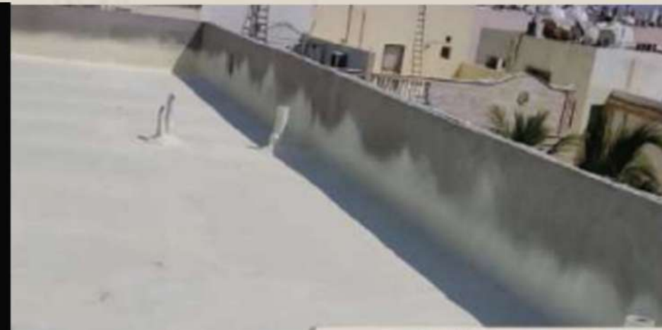
عزل بولي يوريثان فوم Polyurethane foam insulation
