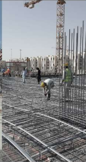
الاعمال الإنشائية لاحقة الشد Post Tensioned Slab
